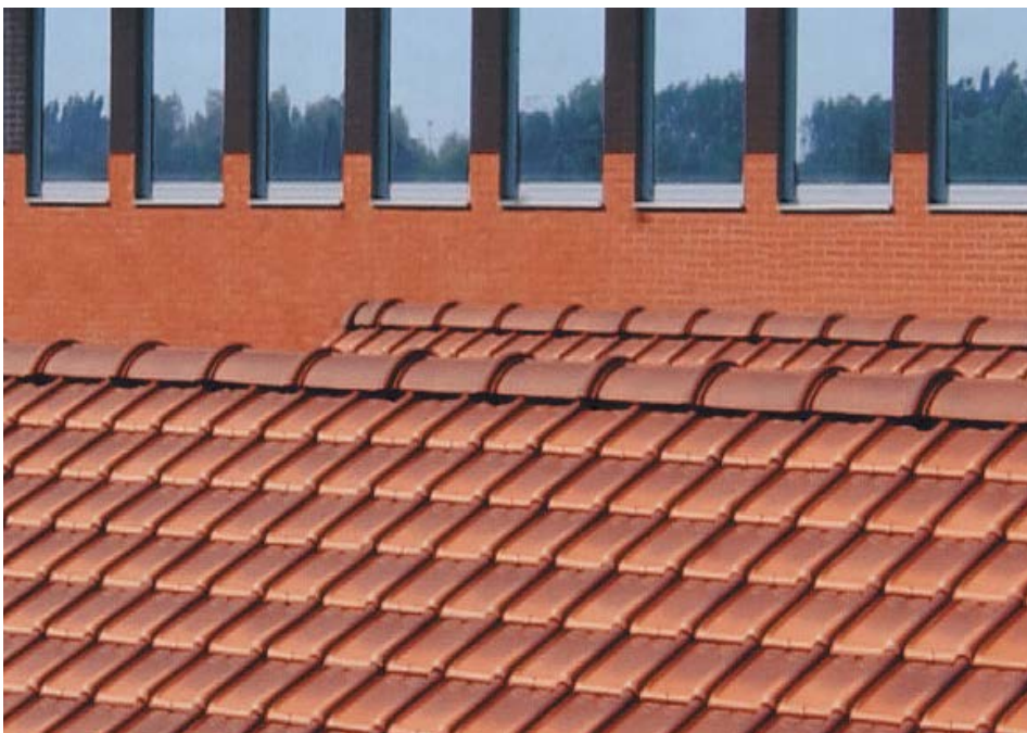
Gebruik van ventilerende ondervorst onder vorsten met sluiting
