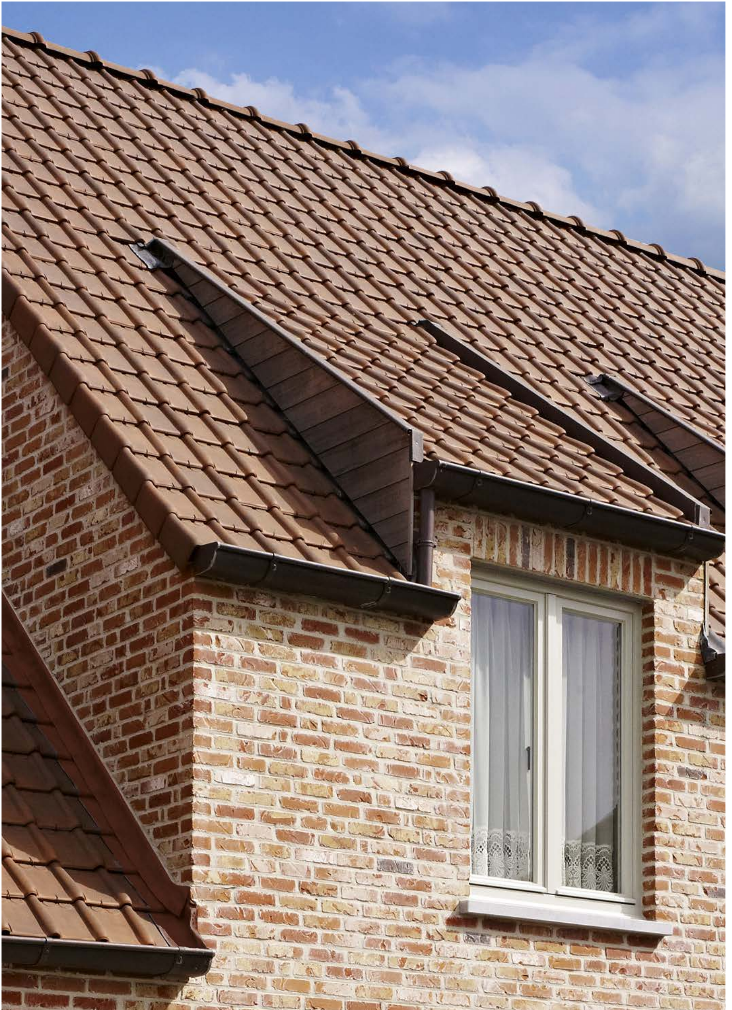
Stormpan 44: verankering van de pannen door gebruik van zichtbare panhaken
