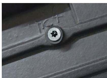
Inox Torx schroef met EPDM-ring voor pannen met sluiting en Oude Pottelbergse pan 451
