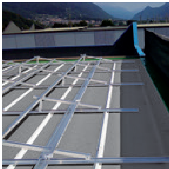
RENOLIT ALKORSOLAR - bevestiging van zonnepanelen zonder de dakbaan te doorboren.
