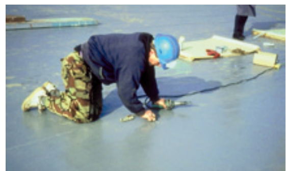
Contrôle des soudures
