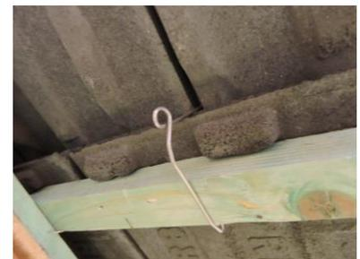
Photo 2: Crochet d'ancrage E-clips type 2 pour la tuile HORIZON ROYAL
