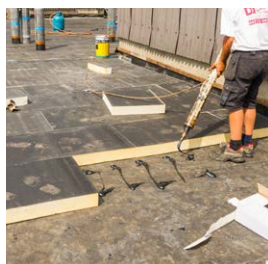
Colle à froid bitumineuse
