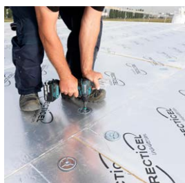
Fixation mécanique
