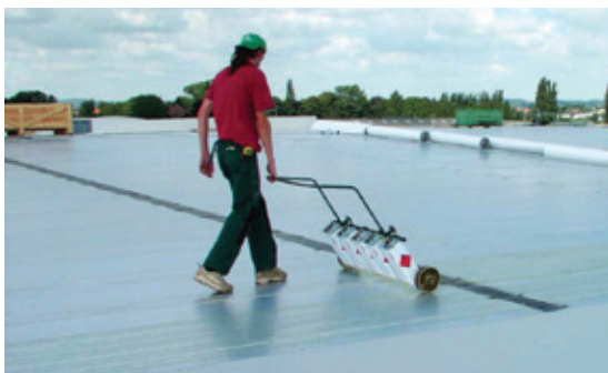
Fig. 1: Aanbrengen van lijm met de rolwagen
