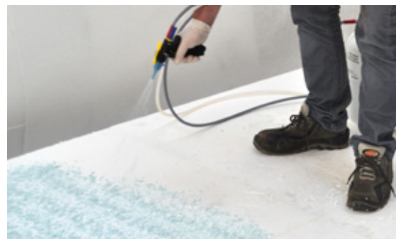
Fig. 2: De RENOLIT ALKORPLUS 81065 lijm wordt aangebracht met een spuitpistool.
