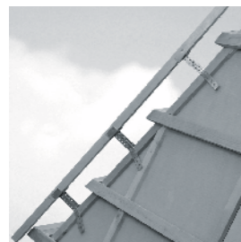
Noklatsteun op hoekkeper.
