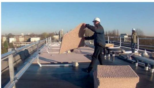
Matériel: tapis en mousse de polyuréthane recyclé avec pores ouverts Dimensions: 1 m x 1m x 3,5 cm
