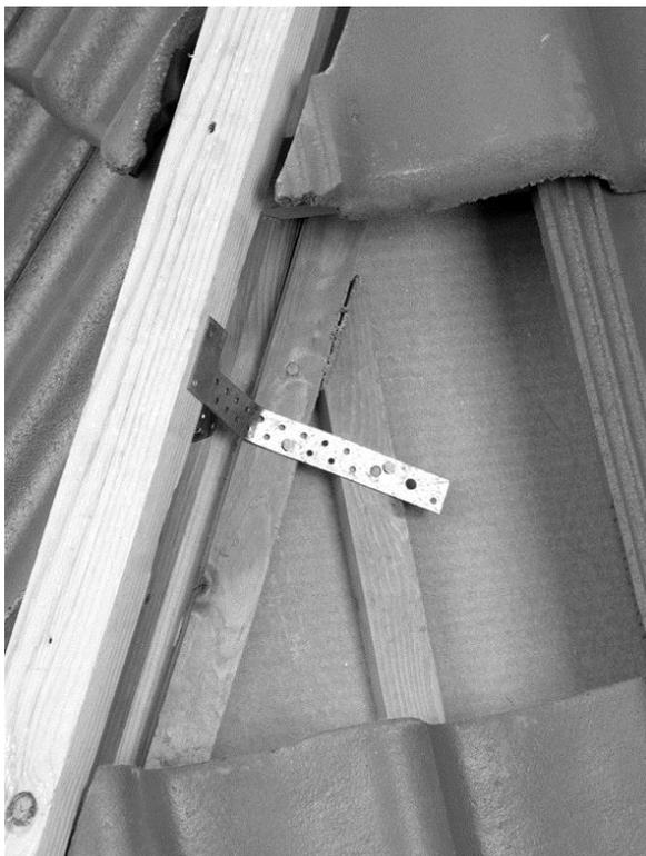
Photo 3: Pose de support de latte sur l'arête
