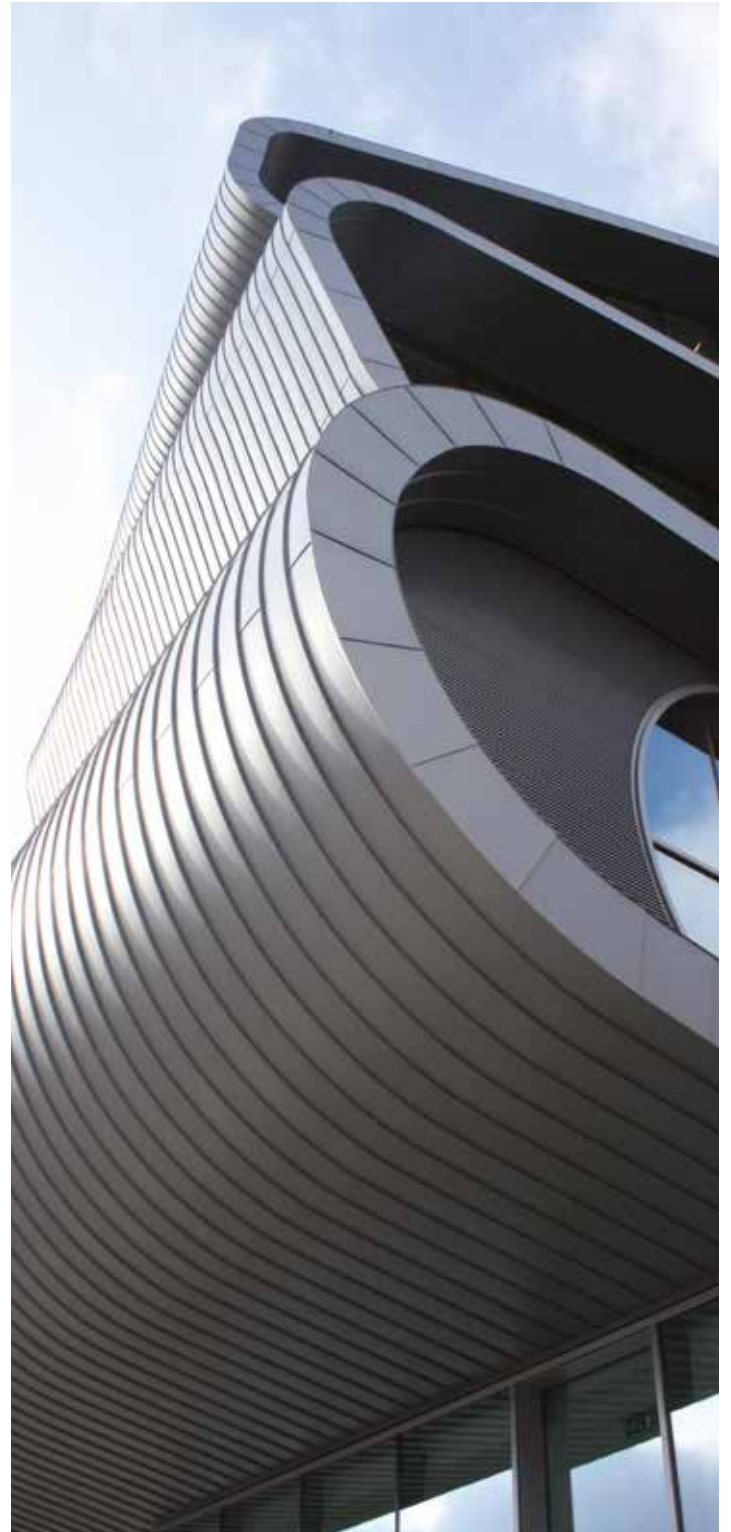
VMZ Staande naad Conix Architects Gebouw Umicore – Hoboken
