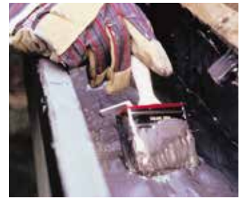
IKO pro Zinkrenovatie
