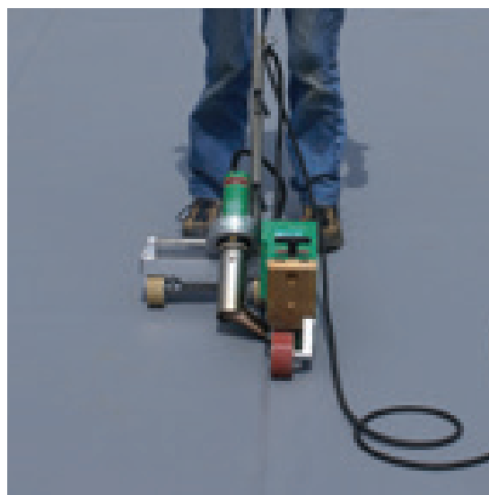
Pose à l'aide d'une machine à air chaud
