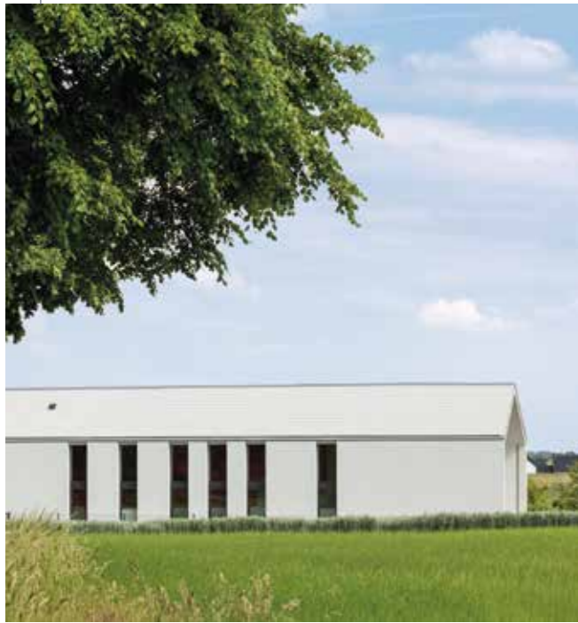
Walhain - Atelier d'architecture Mathen (Corbais)
