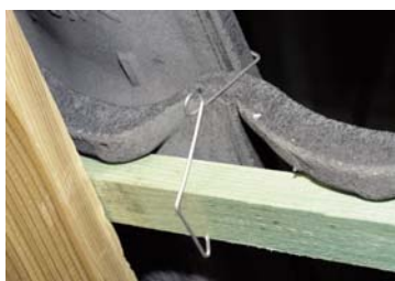
Foto 1: E-clips type 1 panhaak SNELDEK ROYAL betondakpan
