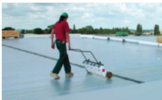
Fig. 1: Application de colle avec un chariot
