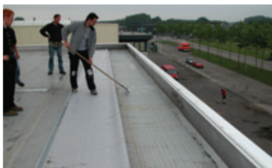
Fig. 2: La colle est répartie d'une manière égale au moyen d'une raclette ou une spatule.
