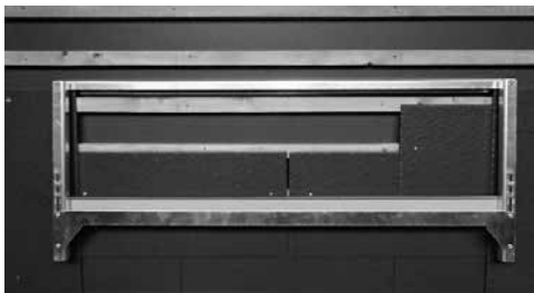
Gabarit de pose pour pose horizontale à recouvrement double
